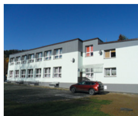
Tył budynku po remoncie
