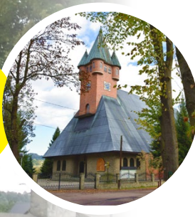
Kościół pw. św. Marcina w Bystrej Podhalańskiej
